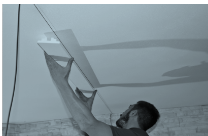
Installazione componenti lineari
