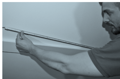
Inserimento dei moduli led facendoli aderire perfettamente al profilo
