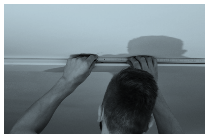
Utilizzare il KIT di connessione per unire le barre led
