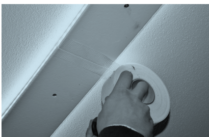
Stuccatura delle fughe e rasatura del sistema JUST1LINE
