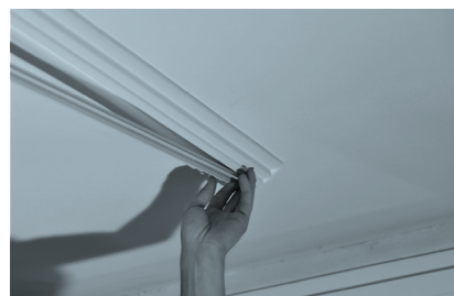
Dopo l'utilizzo del primer si colora il profilo e si inserisce il modulo led
