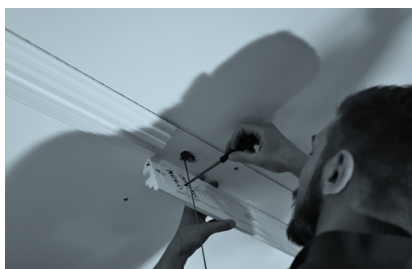
Installazione componenti lineari
