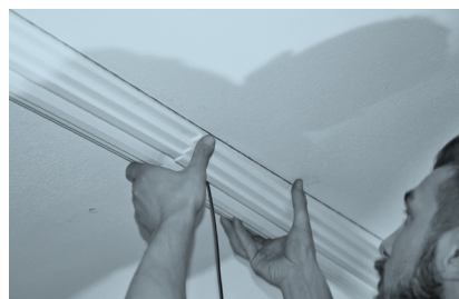
Pressione sul materiale per una perfetta aderenza alla superficie
