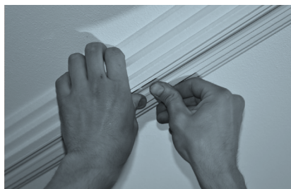
Inserimento della cover di chiusura
