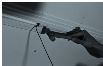
Inserimento dei moduli led facendoli aderire perfettamente al profilo
