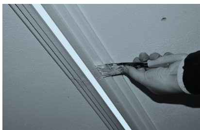
Stuccatura delle fughe e rasatura del sistema JUST1LINE
